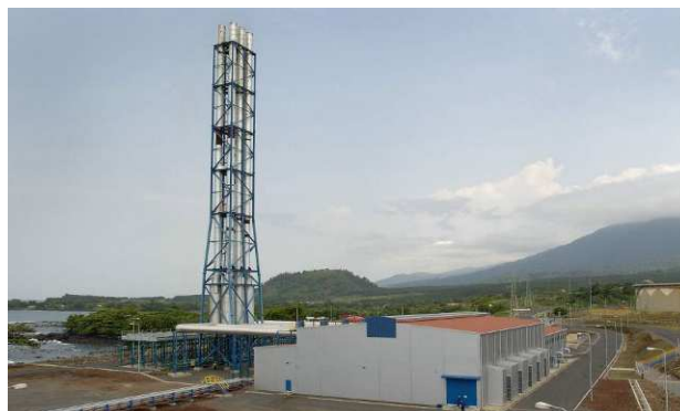
Figure 3 : Vue de la centrale de Limbé ( 85 MW )
